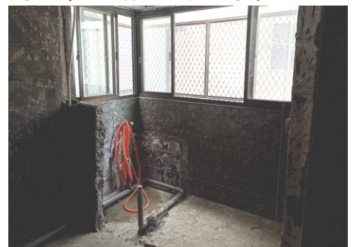
浸池重新施作
